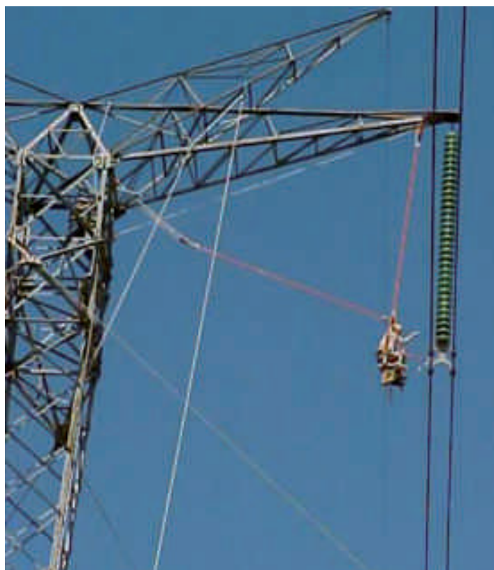
Fig. 5 – Isolador em linha de transporte de energia
